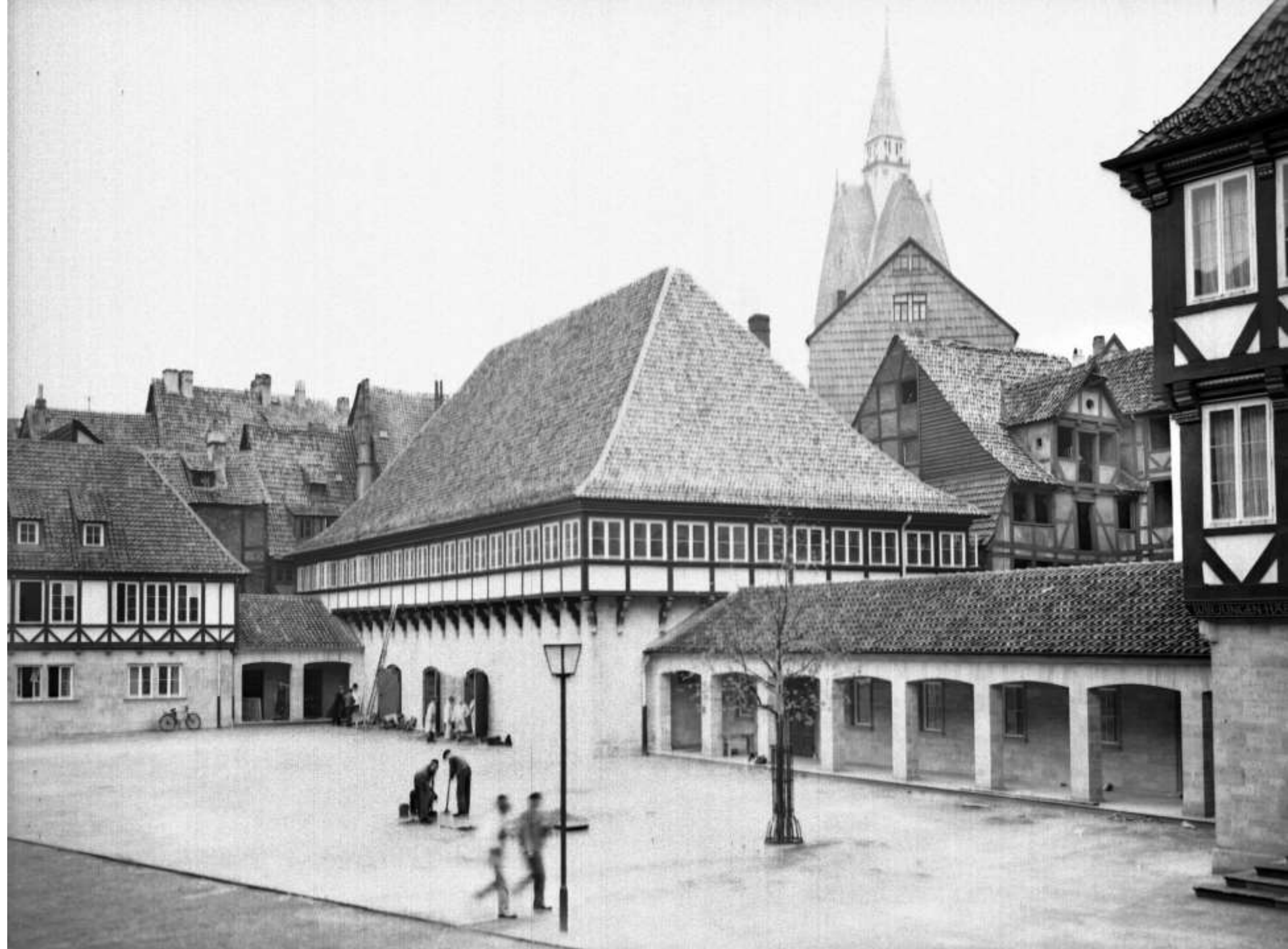
Der neugestaltete Ballhofplatz – Foto Wilhelm Meyer, 1939.
